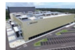
日本ジェネリック つくば第二工場
