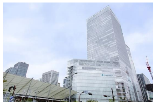
グラントウキョウノースタワー全景
